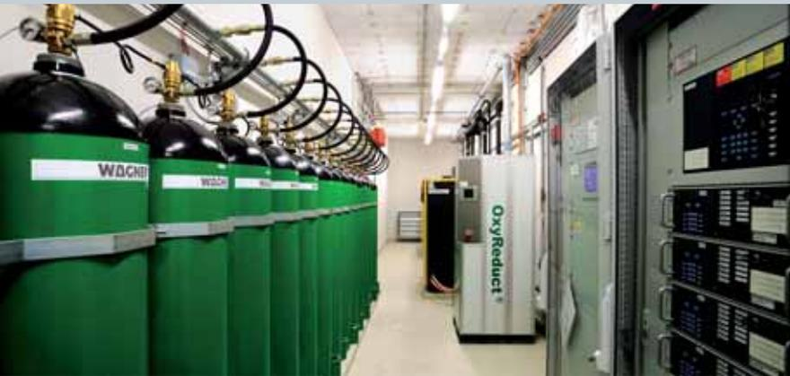
Sistema de prevención de incendios OxyReduct® con reducción rápida del nivel de oxígeno.
