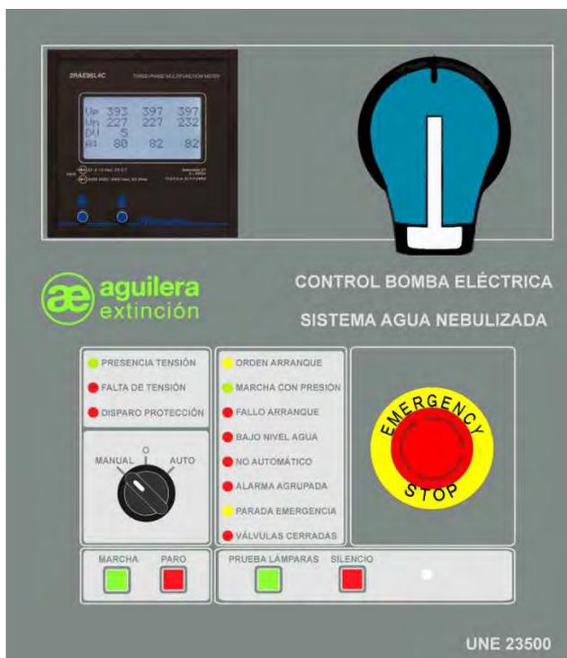
Panel de control de una bomba para instalaciones secas. Se integran los indicadores luminosos asociados al módulo común y al de una bomba principal.
